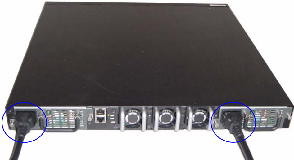
Gambar 2. Menghubungkan Kabel Daya
